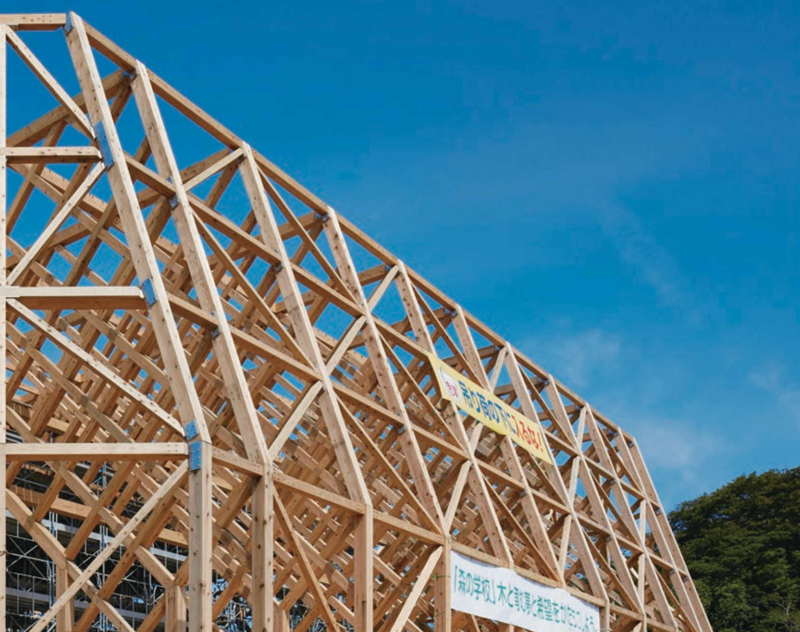
建築中の東松島市の小学校(宮城県)
