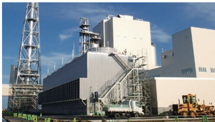
紋別バイオマス発電所 (北海道)
