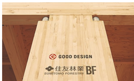
ビッグフレーム構法で使用される、通常の5倍以上の幅の柱(ビッグコラム)
